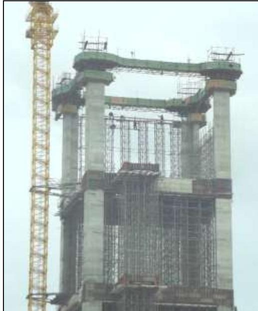
Figura 1: Pilares de obras industriais (preaquecedor da fábrica de cimento Apodi – Quixeré/CE/Brasil)
