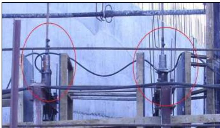
Figura 5: Macaco Hidráulico (fábrica de cimento Apodi – Quixeré/CE/Brasil)
