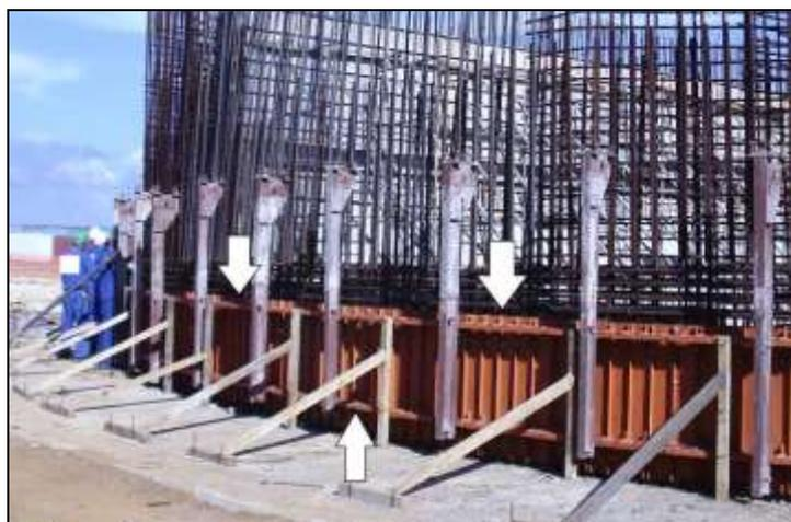
Figura 2: Painéis de liga metálica (fábrica de cimento Apodi – Quixeré/CE/Brasil)
