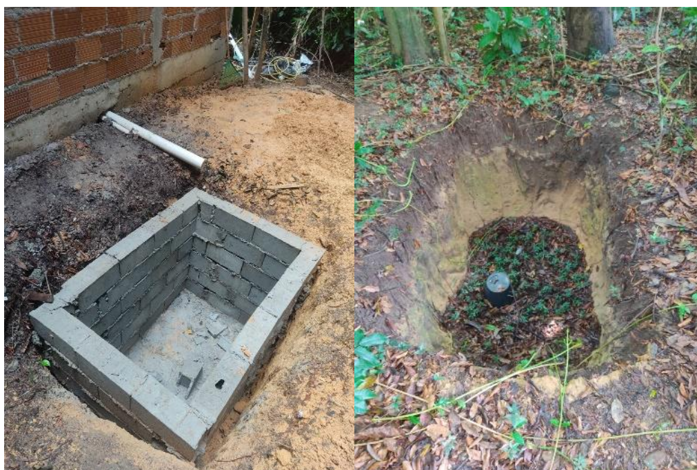
Figura 8 - A esquerda a construção de uma fossa, e a direita o estágio em que a fossa fica depois de longo tempo de uso na Aldeia Pataxó localizada na Reserva da Jaqueira (Porto Seguro – BA).
