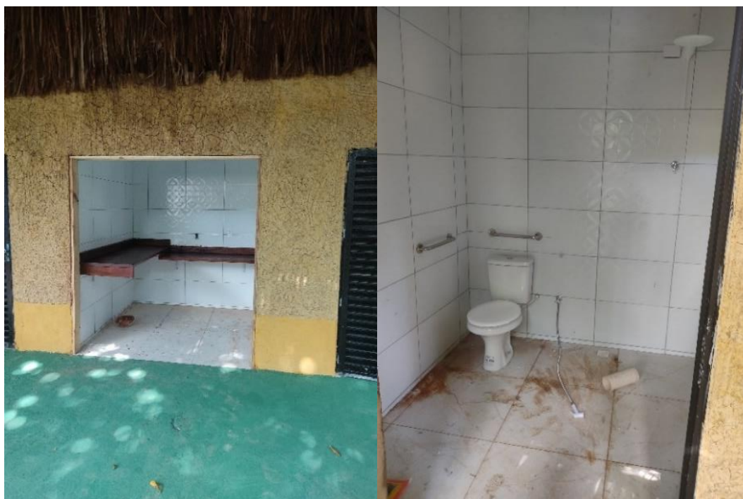
Figura 7 - Banheiros para Pessoas com Necessidades Especiais - PNE na Aldeia Pataxó localizada na Reserva da Jaqueira (Porto Seguro – BA).
